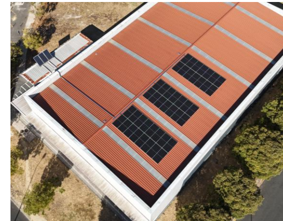
Sistemas fotovoltaicos da CER Telheiras/Lumiar (7.15 kWp ; 25,74 kWp)
